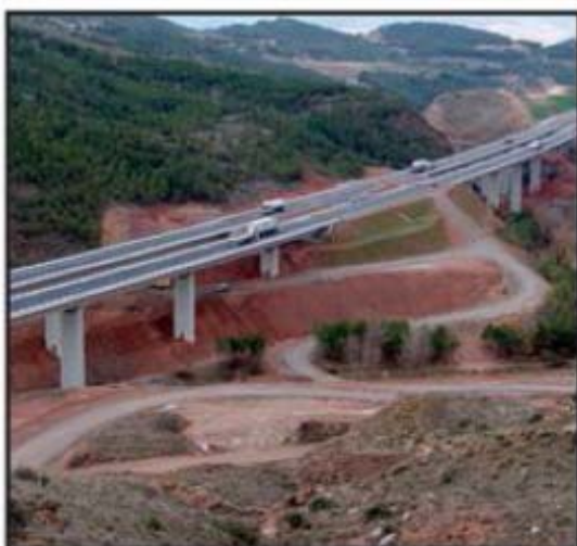
Viaducto en la A-23
