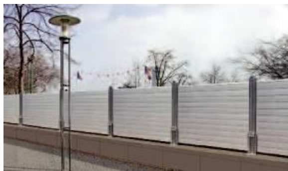
Mobilių sienelių stulpai gali būti iki 2.20 m. Fotografija - IBS
